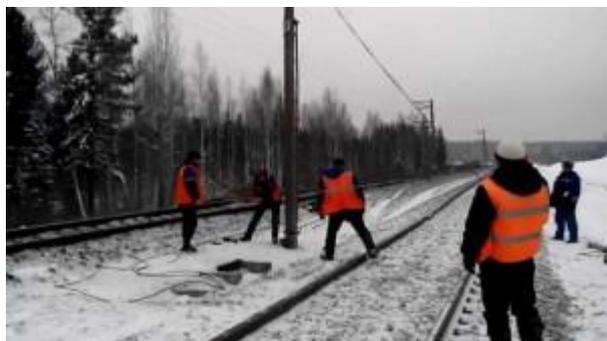
1) Согласно разработанным техническим планам, в схему управления мачтовым светофором вносятся утверждённые изменения. Выполняется необходимый комплекс монтажных работ.
