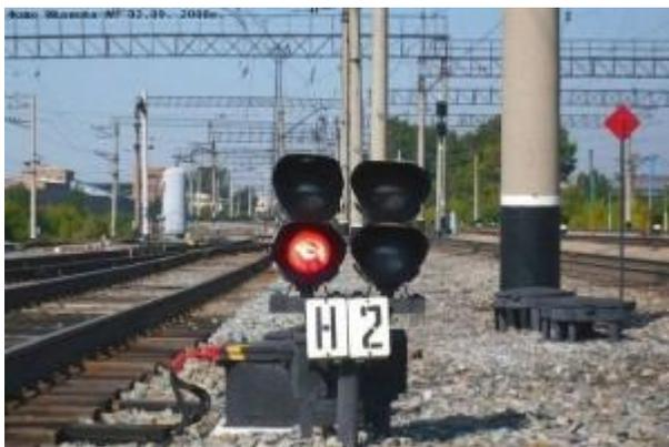
Демонтаж карликового светофора с лампами накаливания начинается с отключения питания светофорных ламп. Старая светофорная головка демонтируется и вывозится в специальное место для дальнейшей утилизации.
