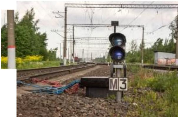
Устанавливаются карликовые светофоры согласно проекта, как правило, с правой стороны в направлении движения поездов. Установка карликового светофора выполняется или над осью ограждаемого пути, или над осью междупутья. Места установки определяются исходя из схематического плана станции.
