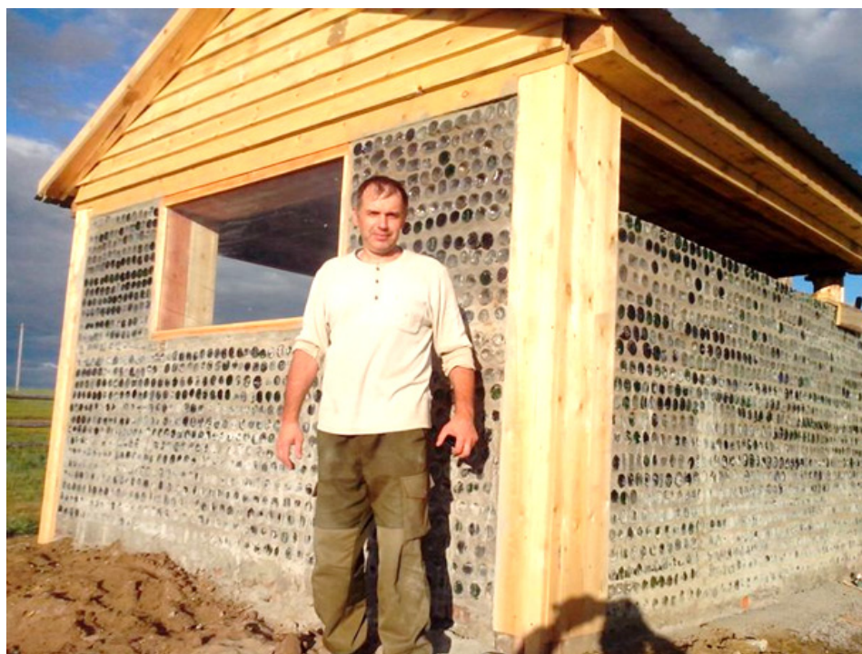
На строительстве экоюрты, июль 2017 г.
