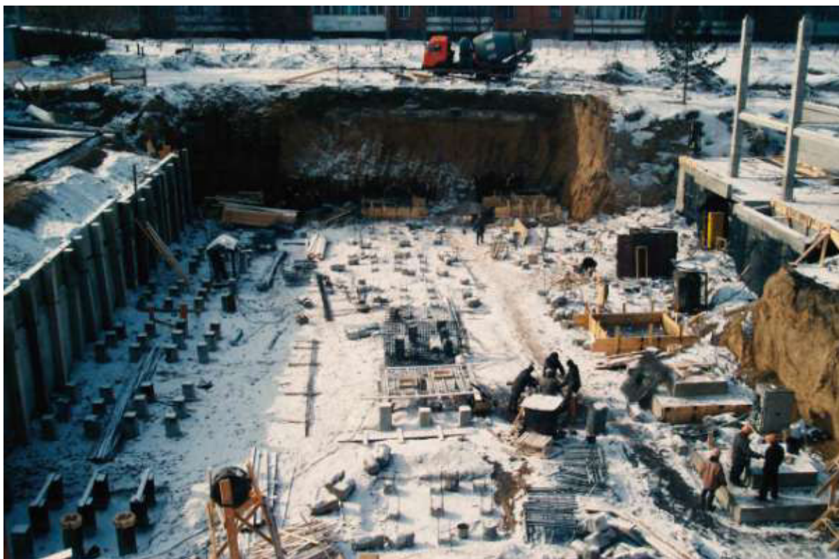
Котлован нового корпуса. 1999–2003
