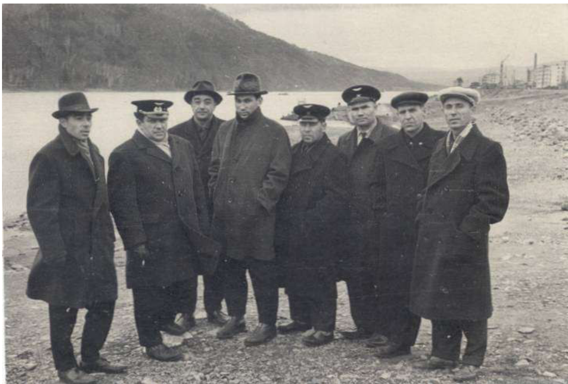
Л. П. Сурков с группой инженеров депо на строительстве Братской ГЭС. 1965
