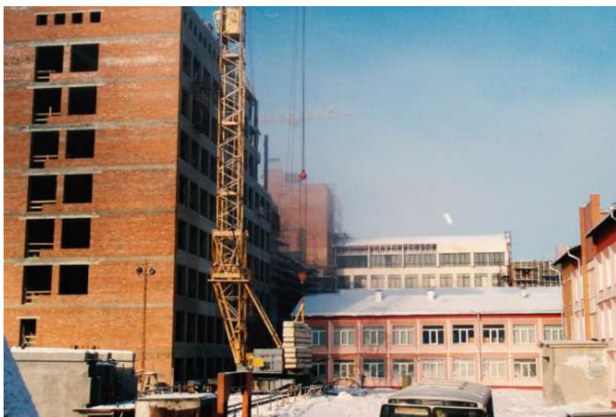
Строительство корпуса Д. 1999–2003
