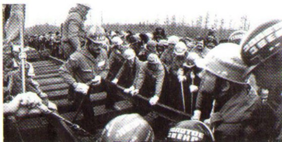
Укладка «золотого звена» на строительстве главного хода железнодорожной БАМа
