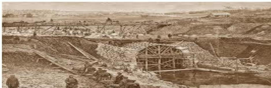
Земляное полотно возводилось сразу под два пути. Впервые стали укладываться широкоподошвенные железные рельсы. По настоянию Мельникова ширина колеи была установлена равной 5 футам или 1524 миллиметра. Она стала стандартной для всех дорог России. Строителям для преодоления водных преград пришлось возвести 8 больших и 182 средних и малых мостов.
