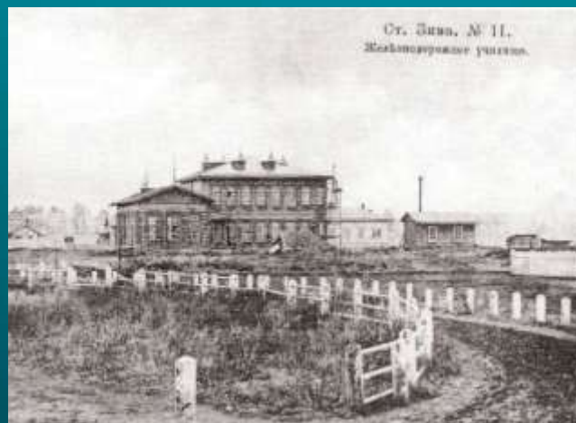
Станция Зима. Железнодорожное училище
