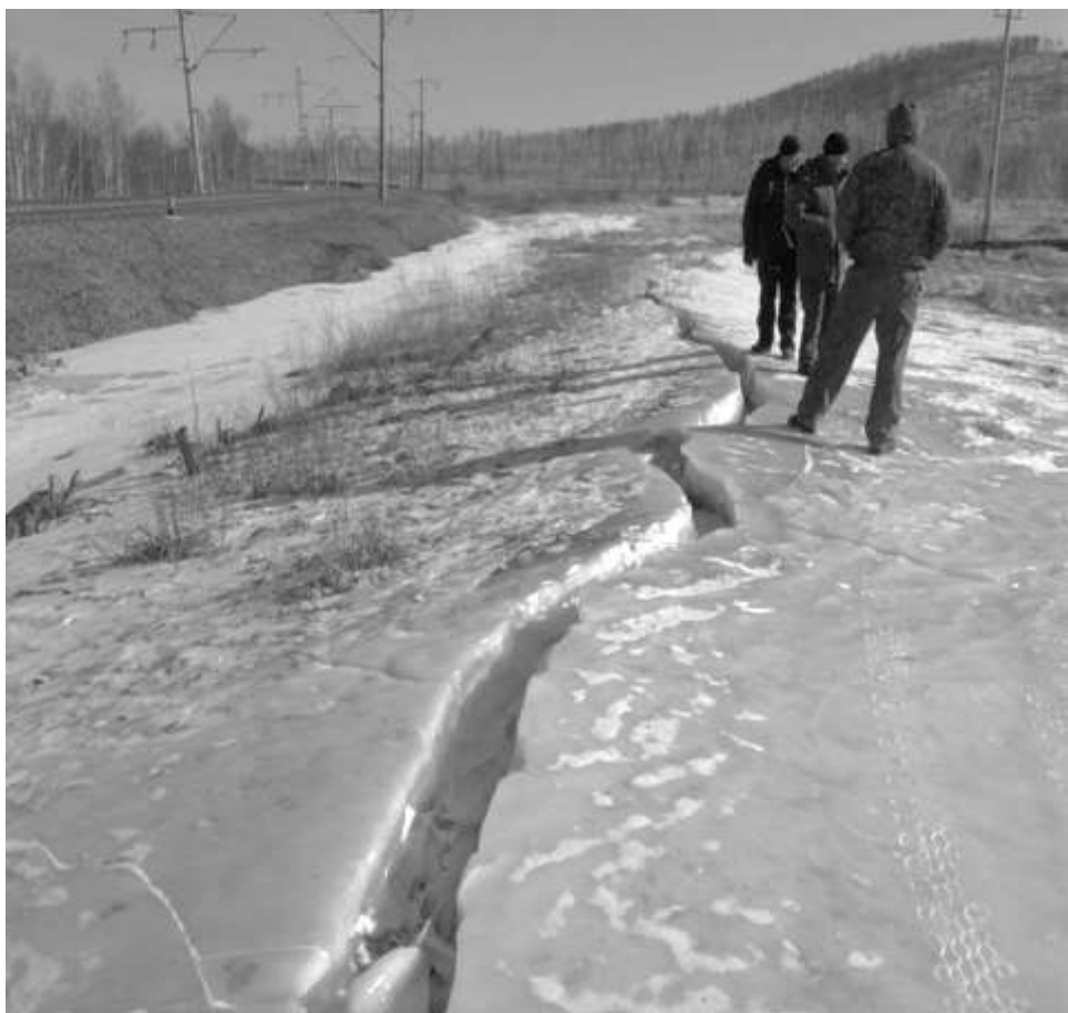
Рисунок 1 – Образование бугра наледи высотой 3,65 м у железнодорожной насыпи
