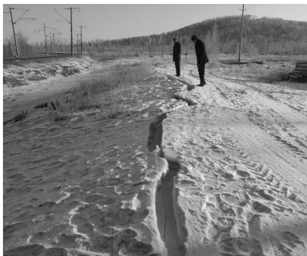
Рис. 3. Образование бугра наледи перед мостом высотой до 3 м
