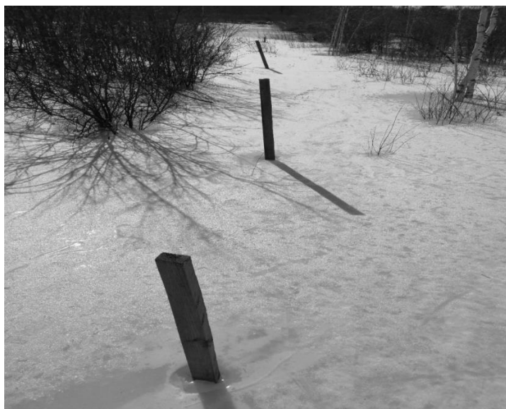
Рис. 7. Разрушенный противодиффузионный экран
