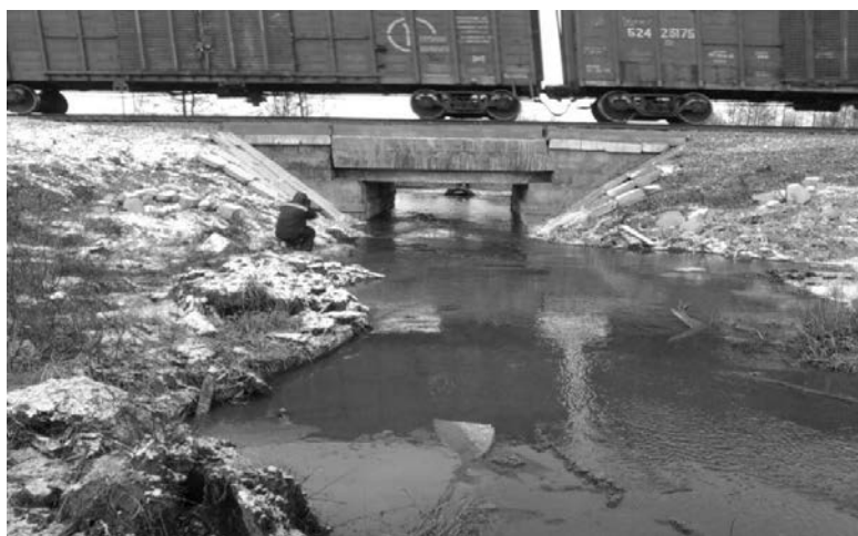
Рис. 1. Пропуск воды под железнодорожным мостом на ПК 3+75
