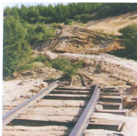
Рис. 2. Разрушение железной дороги на Сахалине при Нefтегорском землетрясении 1995 г
