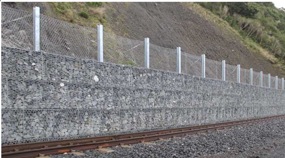
Рис. 2. Конструкция габионов
