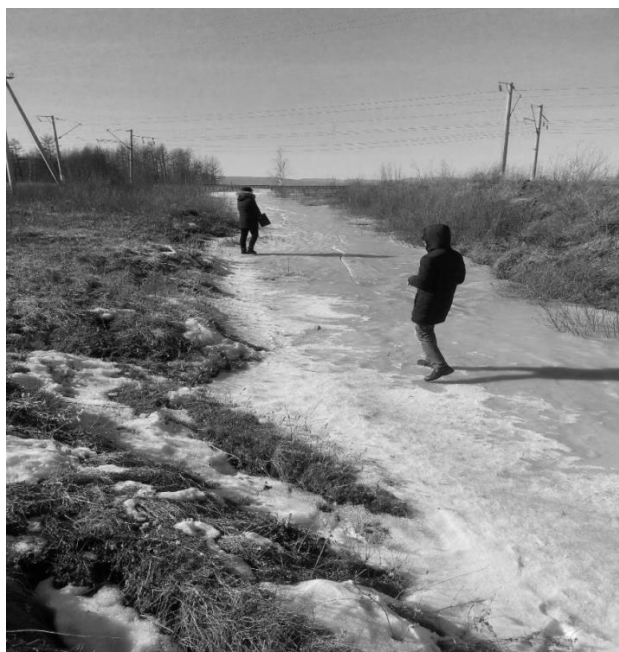
Рис. 4. Нивелировка наледи в руслоотводном канале
