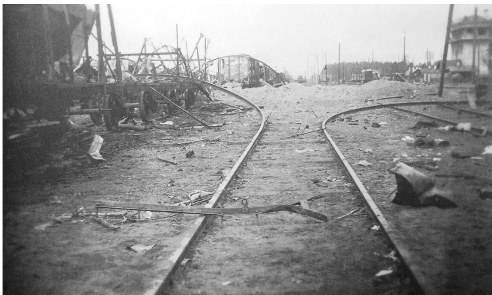
Рис. 3. Разрушенная станция Мга
