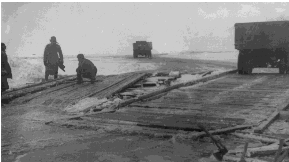
Рис. 4. Работы по строительству Дороги жизни
