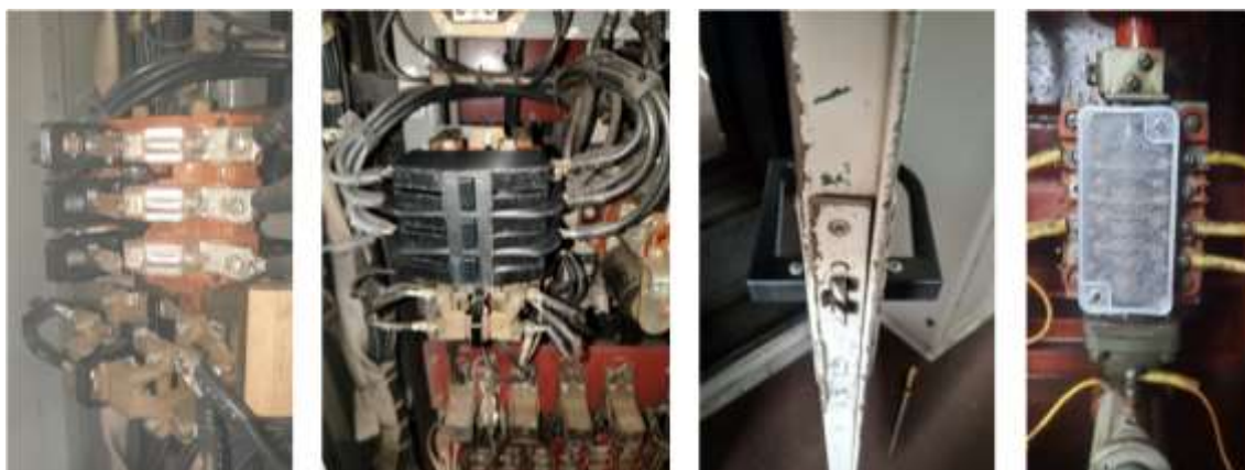
Рис. 11. Установка деталей на МВПС
