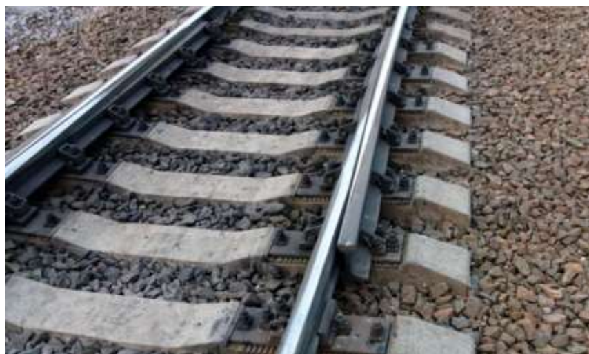
Рис. 3. Клиновые компенсаторы
