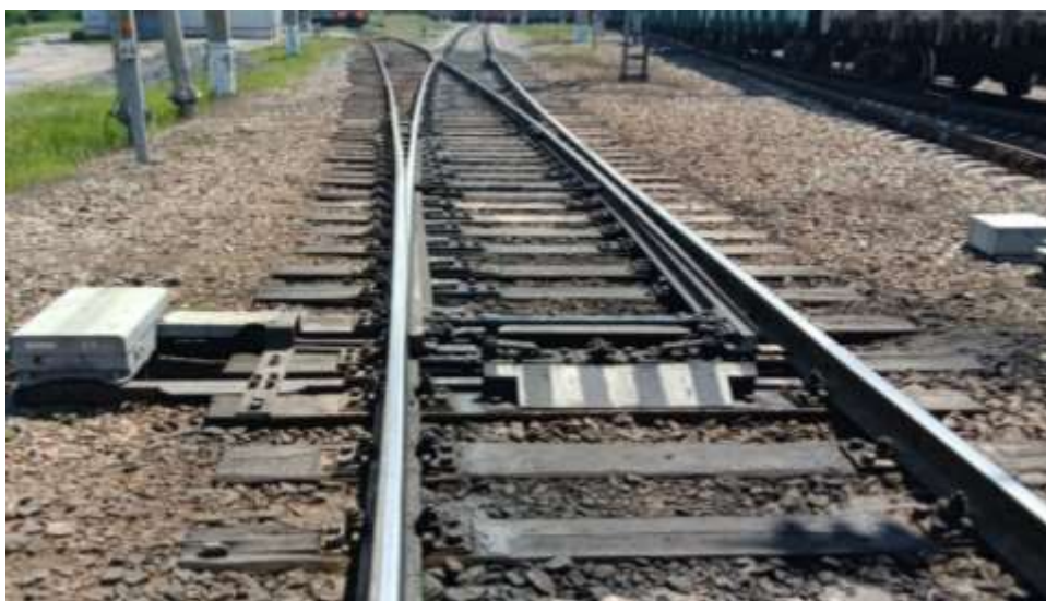
Рис. 1. Стрелочный перевод № 13 на станции Тургутуй после проведения работ
