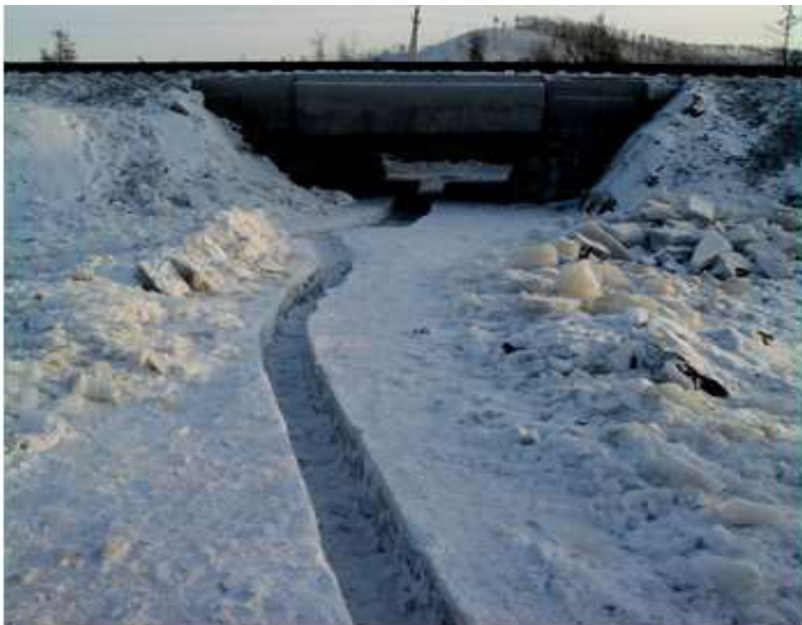
Рис. 1. Наледные процессы под железнодорожным мостом в зимний период
