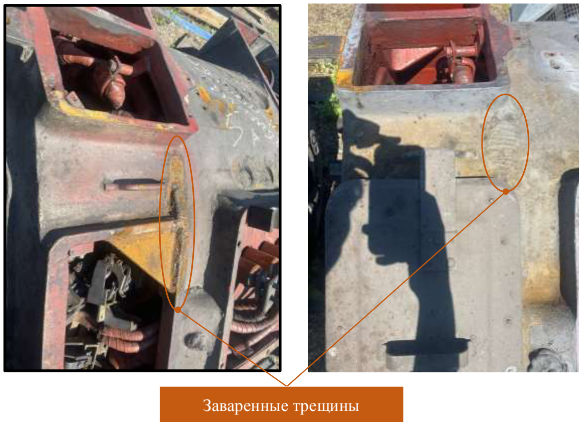
Рис. 2. Заваренные трещины остова тягового электродвигателя электровоза серии ЗЭС5К
