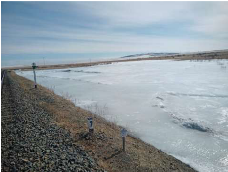
Рис. 4. Вид на наледь по ходу километров
