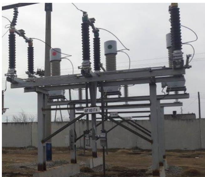
Рис. 1. РНДЗ-2-110/1000 с фарфоровой изоляцией
