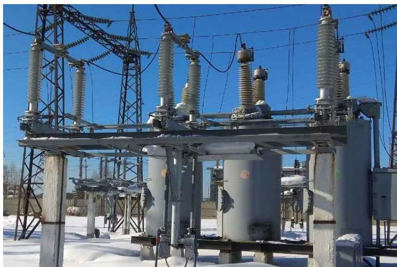
Рис. 2. РНДЗ-2-110/1000 с полимерной изоляцией
