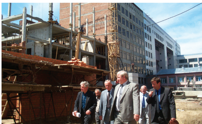
Достраивается корпус «Д», строится корпус «Е», 2003 г.
