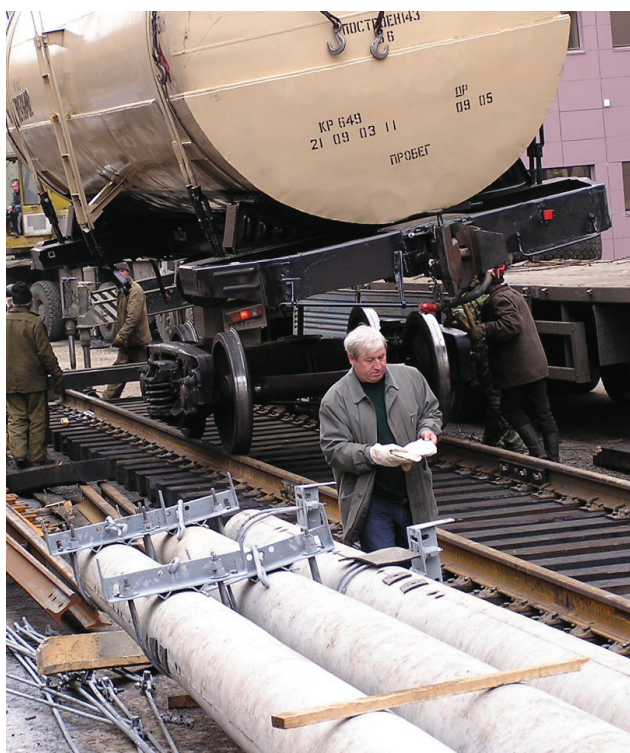
На строительстве учебного полигона
